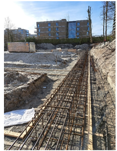
foto van de funderingswapening
